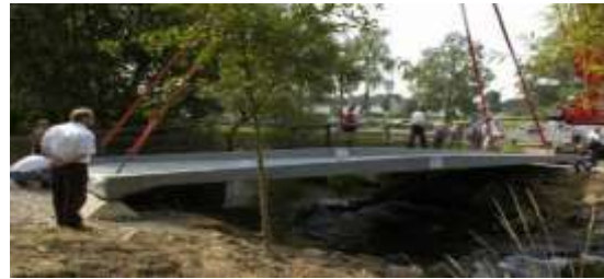
(d) Niestetal footbridge in Germany
