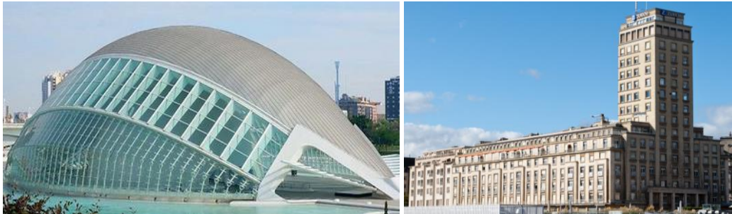
Figure 4-3 Hemisfèric and Bel-Air tower
